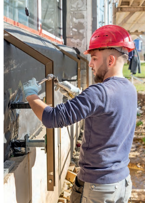
^ Jede Fassade braucht eine gut montierte Unterkonstruktion.
